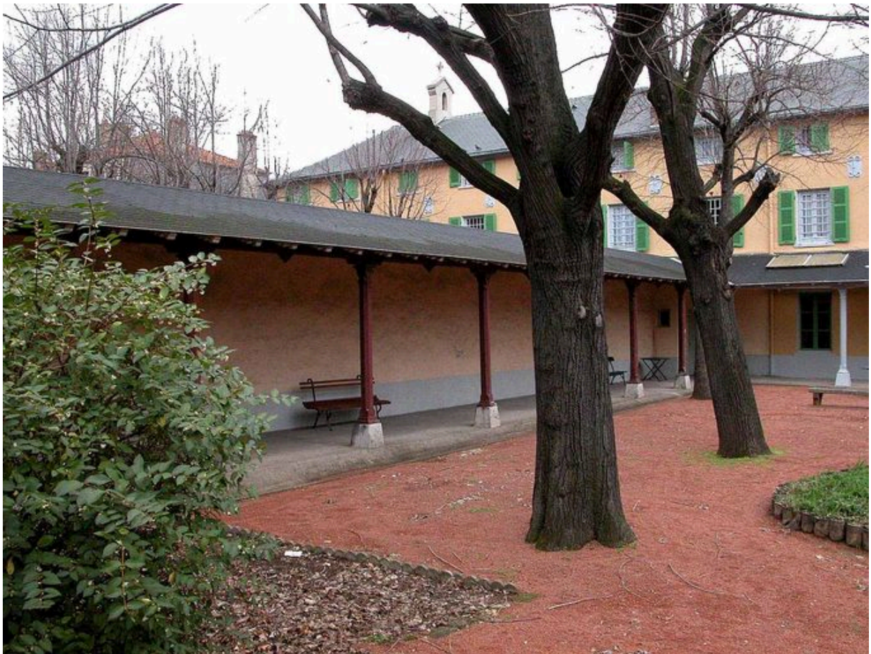
Cour nord-ouest, vue des portiques avant remaniement
