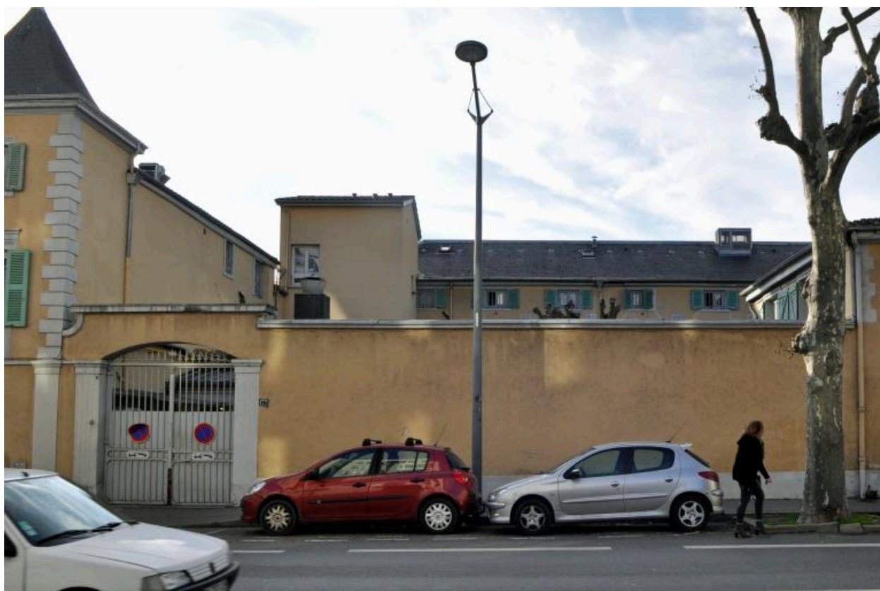
Aile nord, vue partielle depuis la route de Vienne
