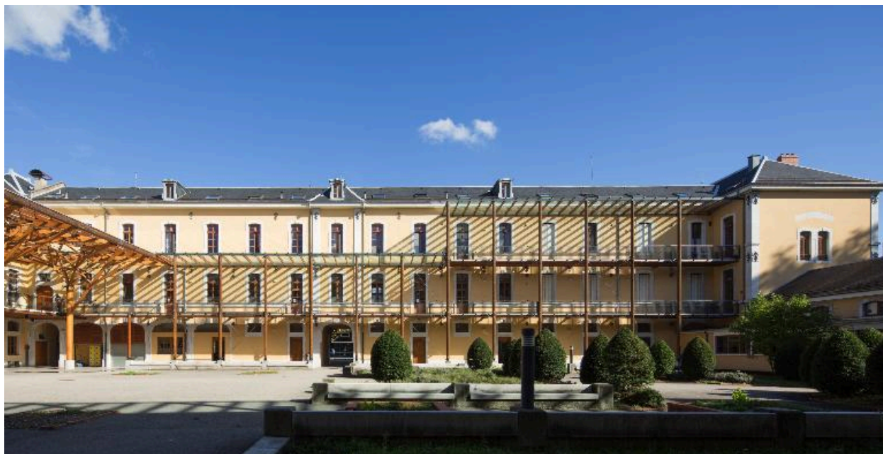
Cour 2 : galerie sur bâtiment est.
