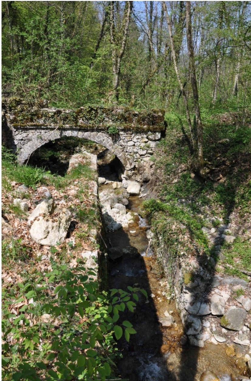
Vue des vestiges de la scierie en amont de l'ancien pont
