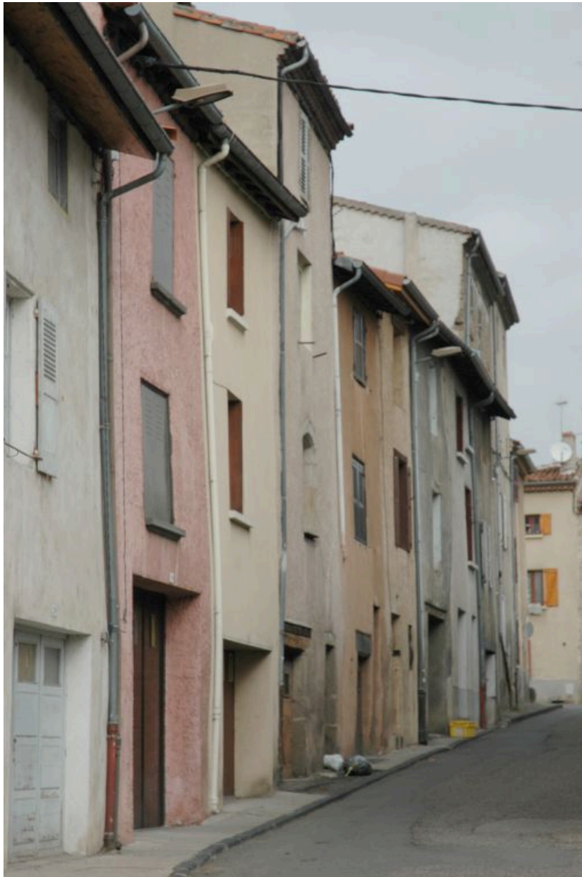
Vue de situation sur la rue Bourgneuf (4e maison à partir de la gauche).
