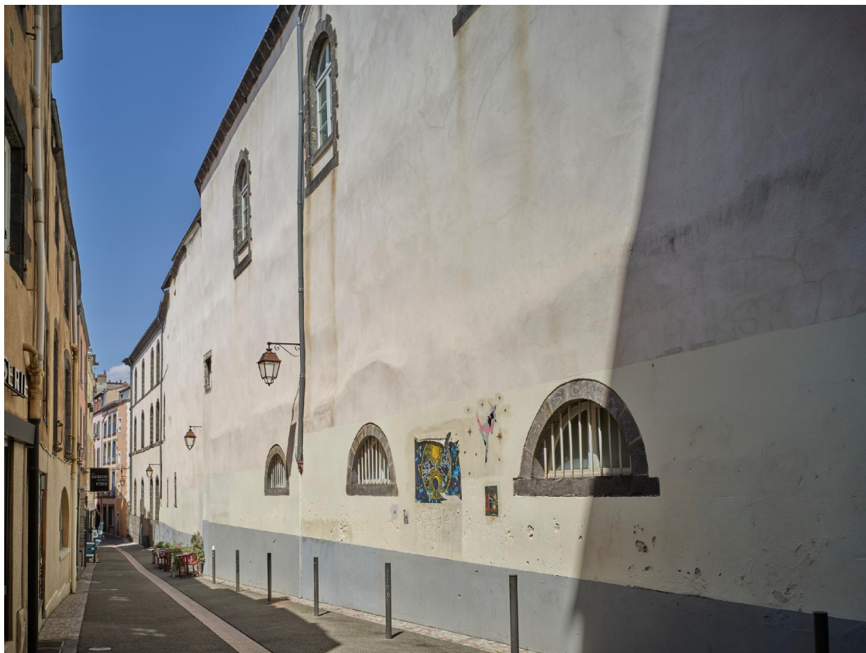
Elévation latérale ouest : vue d'ensemble
