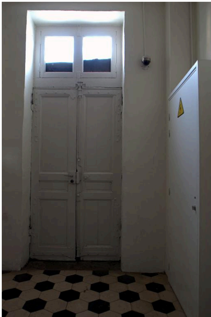
Bâtiment C, rez-de-chaussée : porte ouvrant sur la cour, depuis l'intérieur
