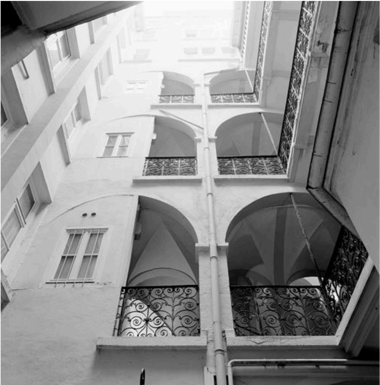
1er bâtiment, élévation sur cour
