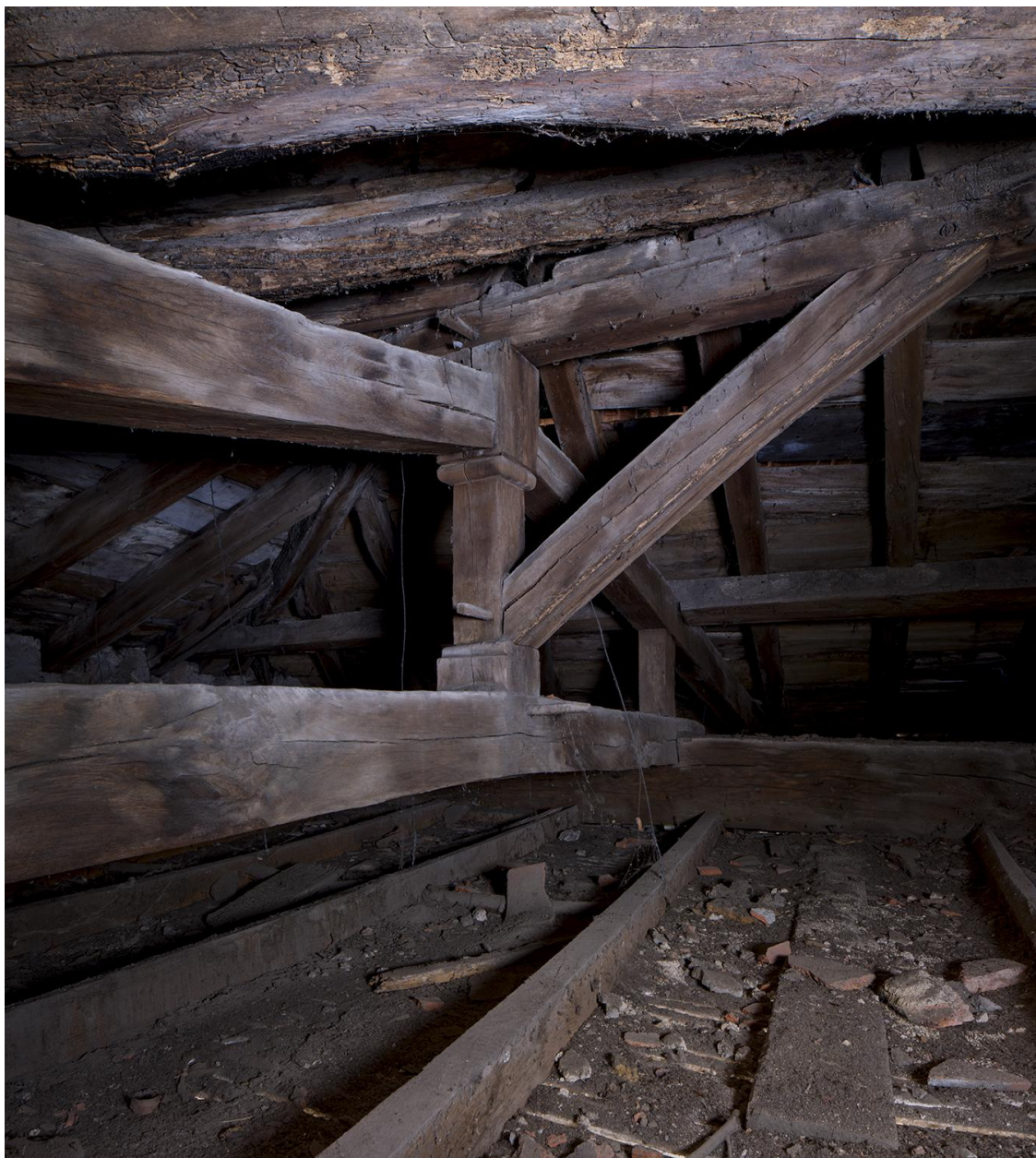
Etage de comble, charpente située au-dessus du dégagement.
