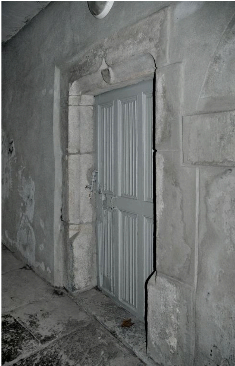
Porte du logis depuis le vestibule d'entrée : encadrement en cavet et linteau en accolade avec écu, vantail à plis de serviette.
