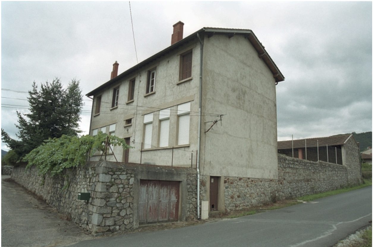
Vue d'ensemble de la façade avant de l'école et de son mur d'enclos.
