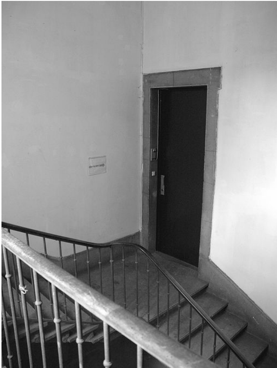
Bâtiment de la galerie, escalier, porte sur le premier palier
