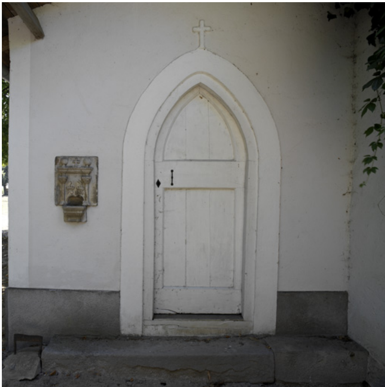
Façade principale : porte d'entrée et bénitier daté 1723.
