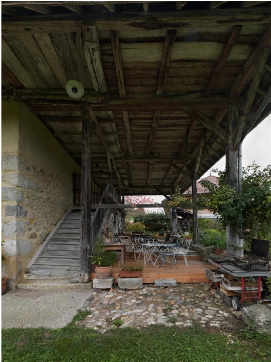
Vue de la galerie en retour sous l'avancée de toiture du pignon nord-est
