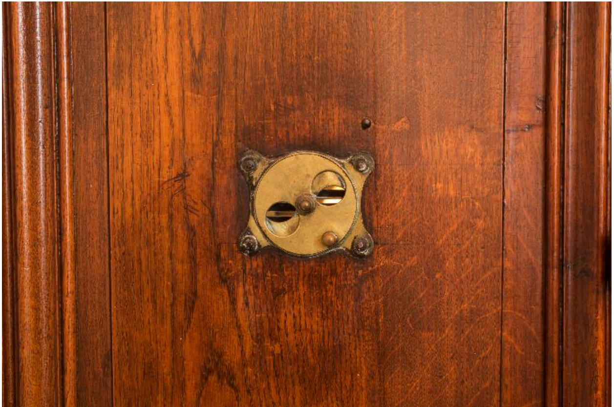
Détail sur la porte de l'appartement du proviseur
