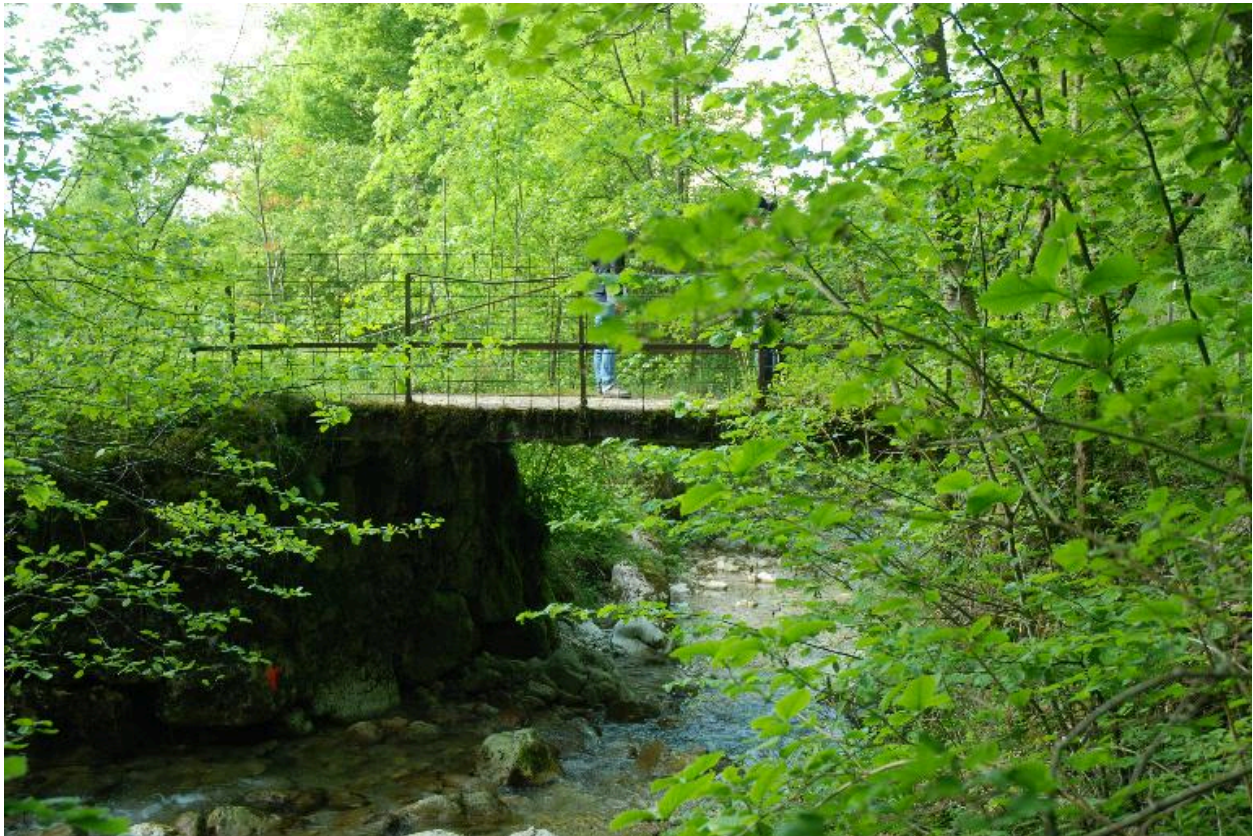
Vue d'un pont sur le Sierroz, en limite de commune, à la Perrière (vers 2013 B4 447).
