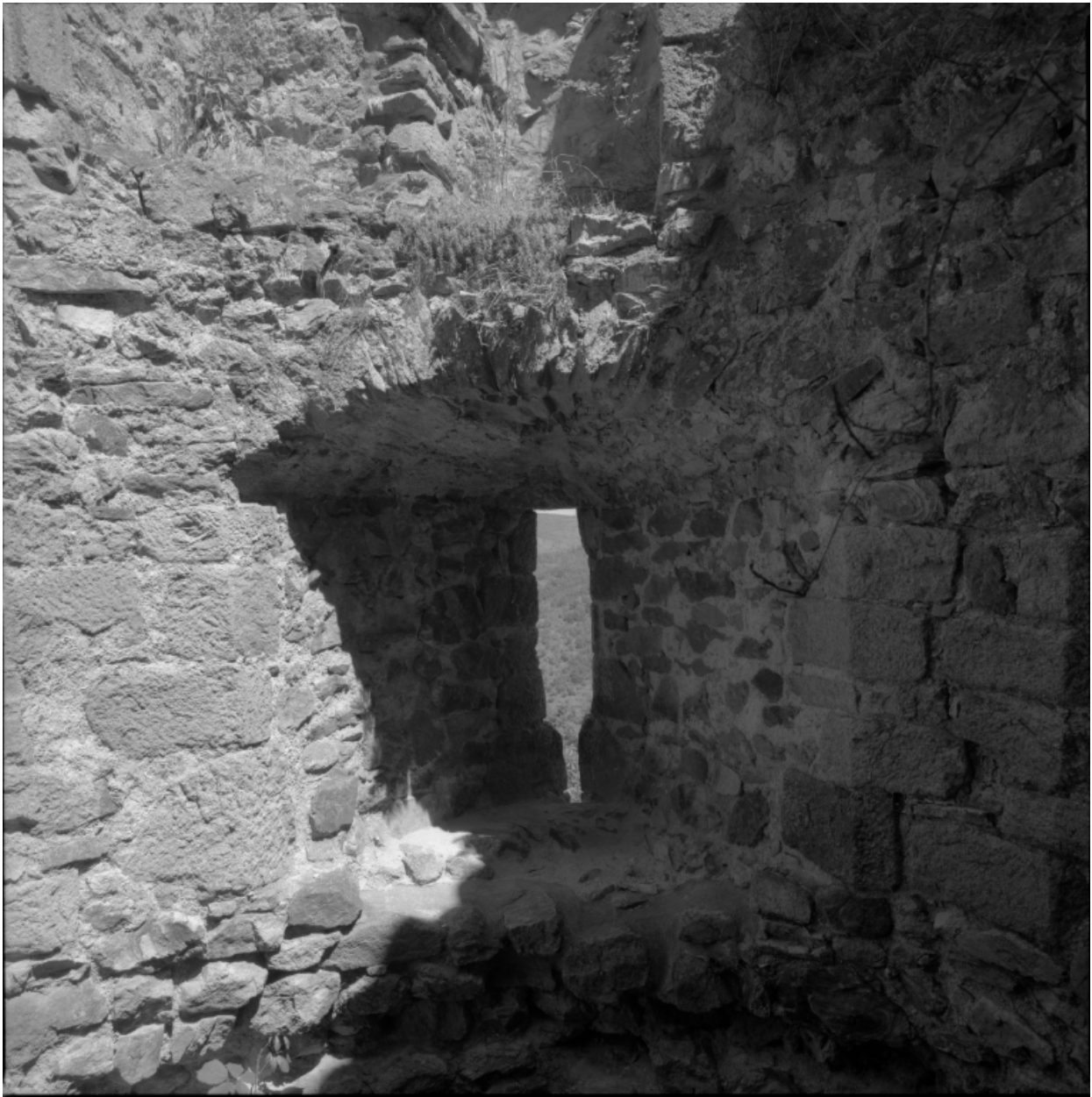
Première enceinte, partie nord, tour ronde (tour n°10 du plan), premier niveau : vue intérieure de l'archère à étrier ouvrant sur l'angle, du sud.
