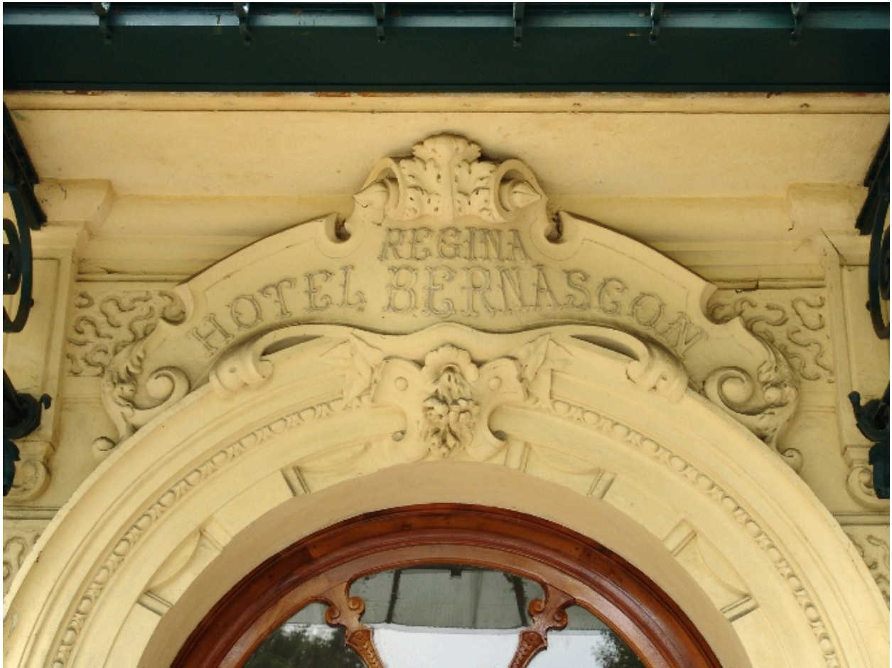
Couronnement de la porte d'entrée
