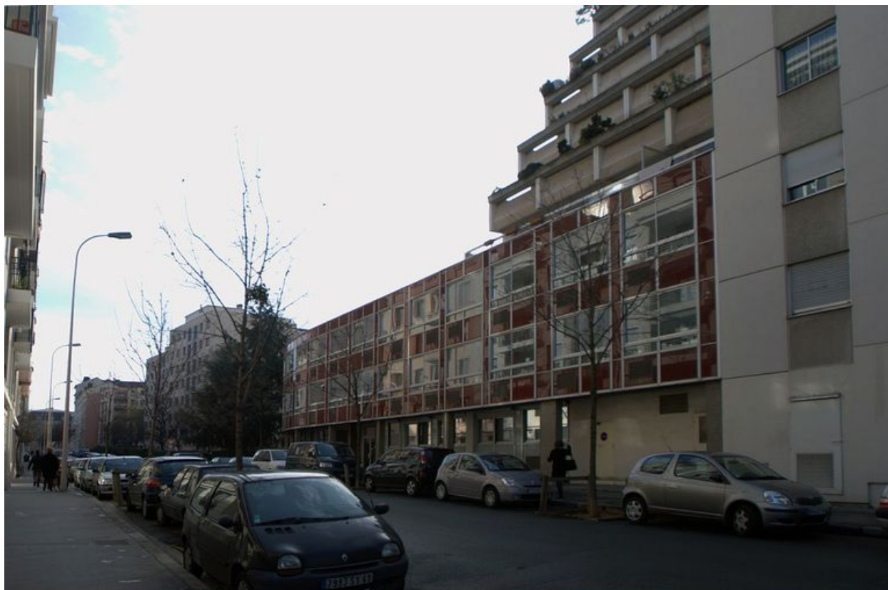
Elévation antérieure, depuis le nord
