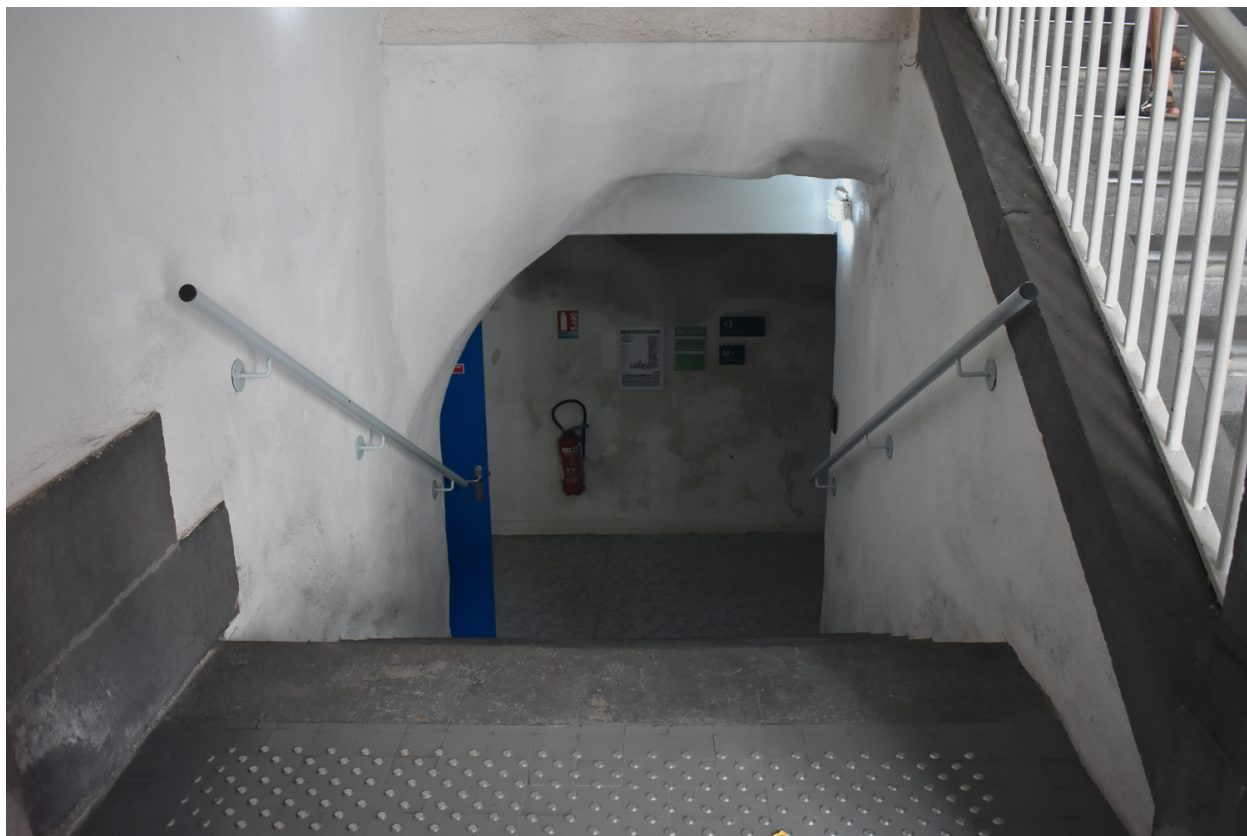
Escalier A : volée descendant à l'étage de soubassement
