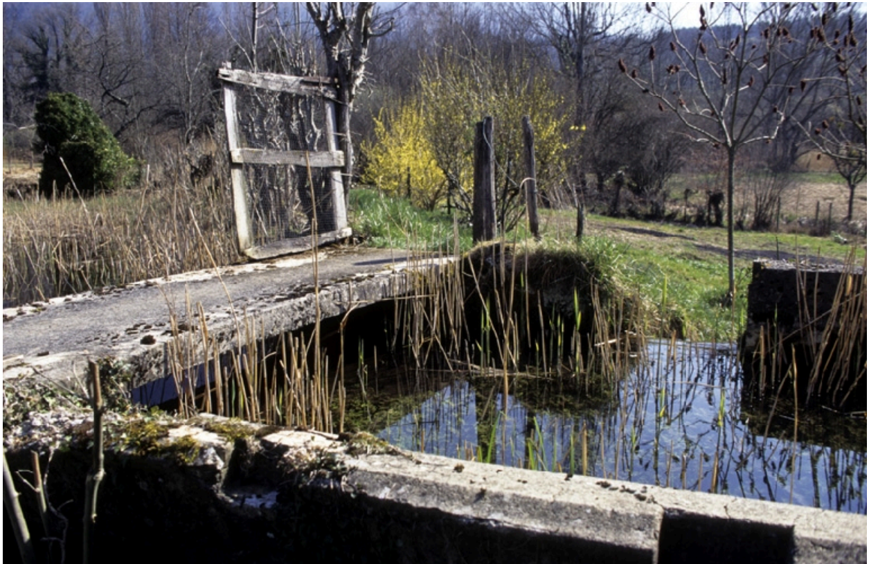
Détail du bassin d'alimentation
