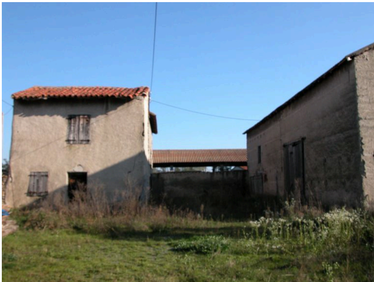
Vue d'ensemble de l'ancien logis et d'une grange-étable de la ferme AO 35.
