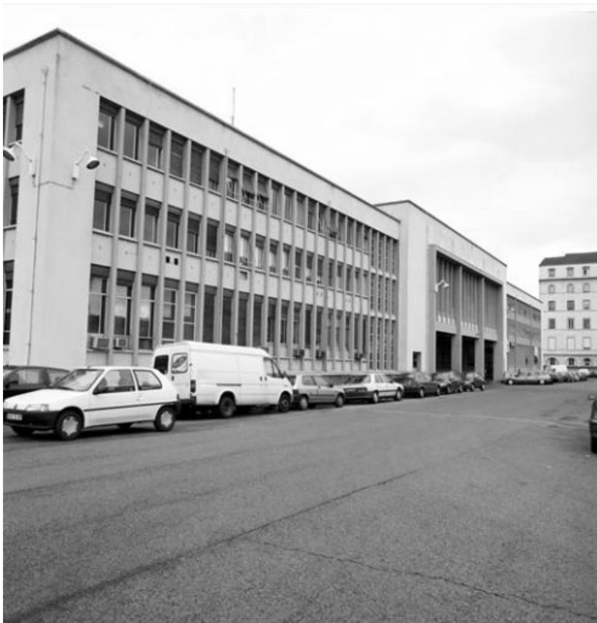
Bâtiment administratif : l'élévation sud
