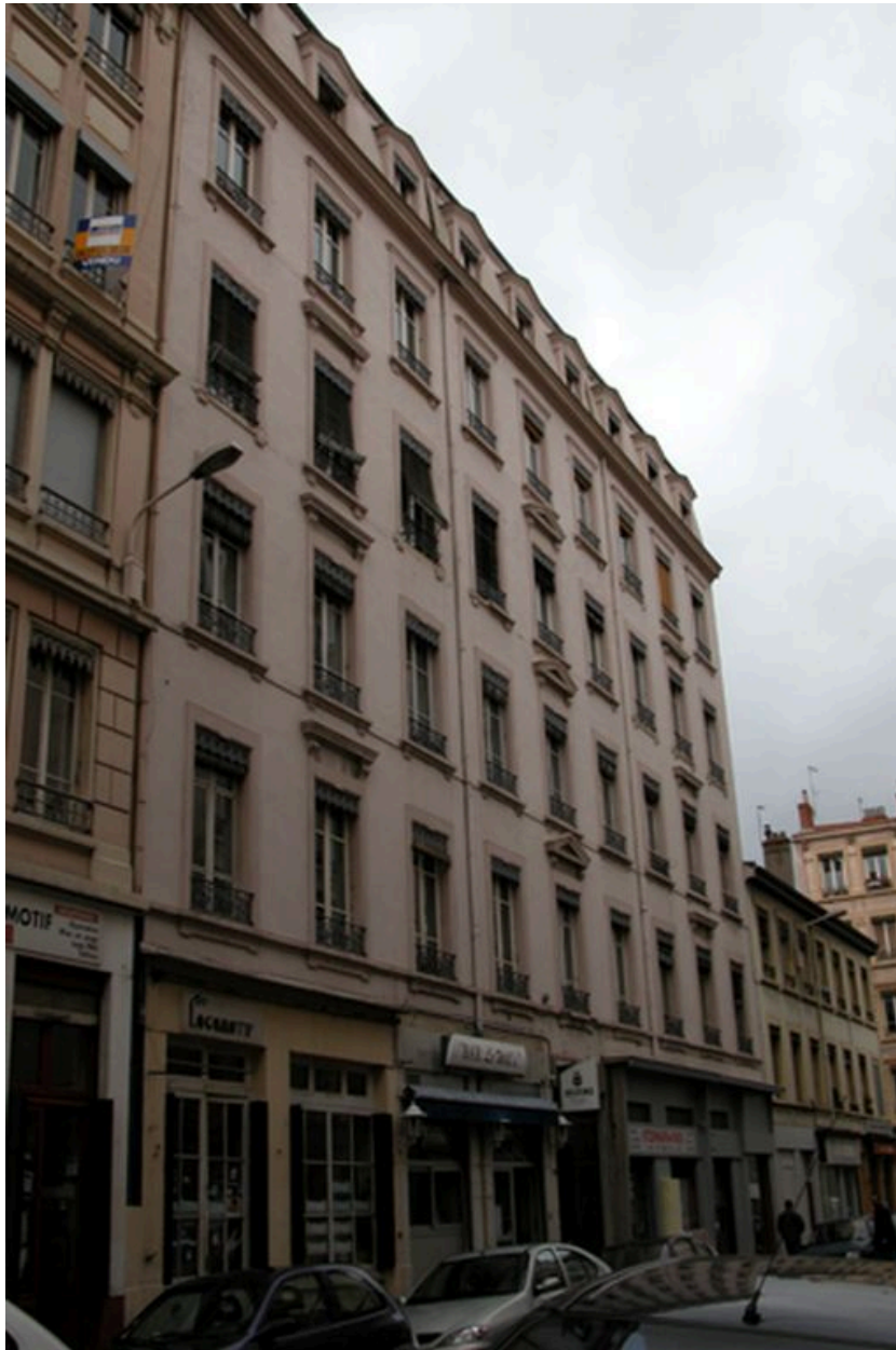
Elévation principale, depuis le nord
