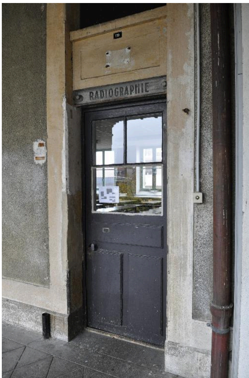
Bâtiment A. Porte sur cour, détail
