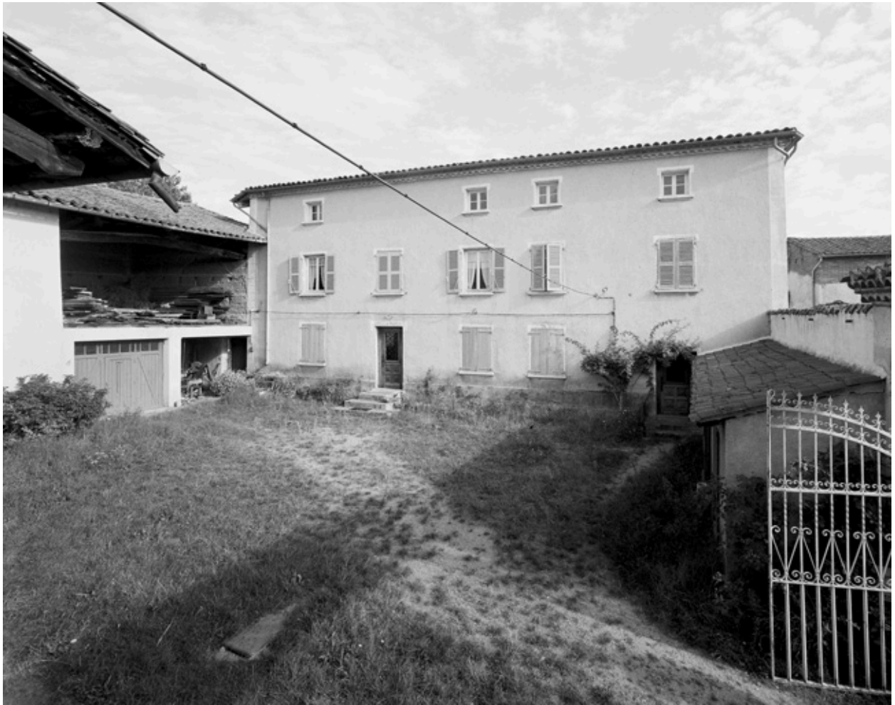
Vue d'ensemble du logis depuis le sud.
