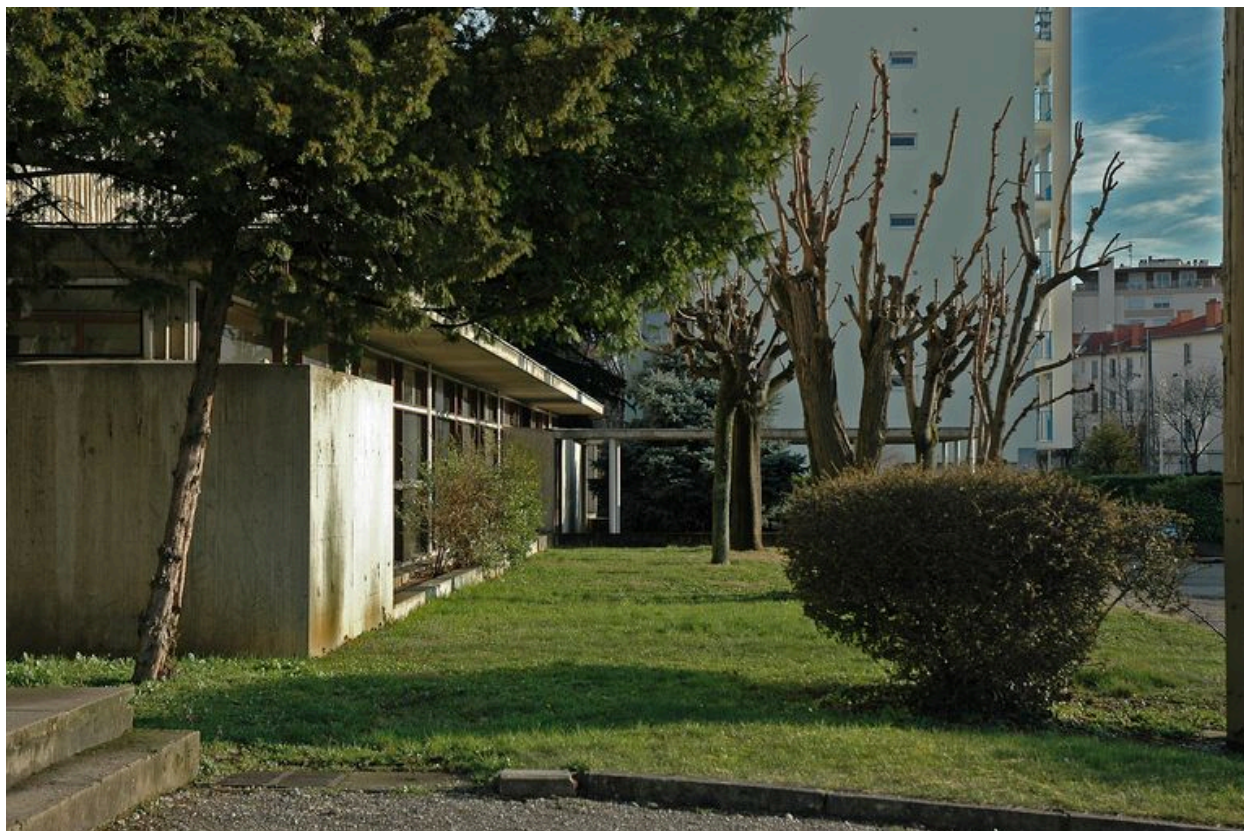
Vue du bas-côté ouest, depuis le nord
