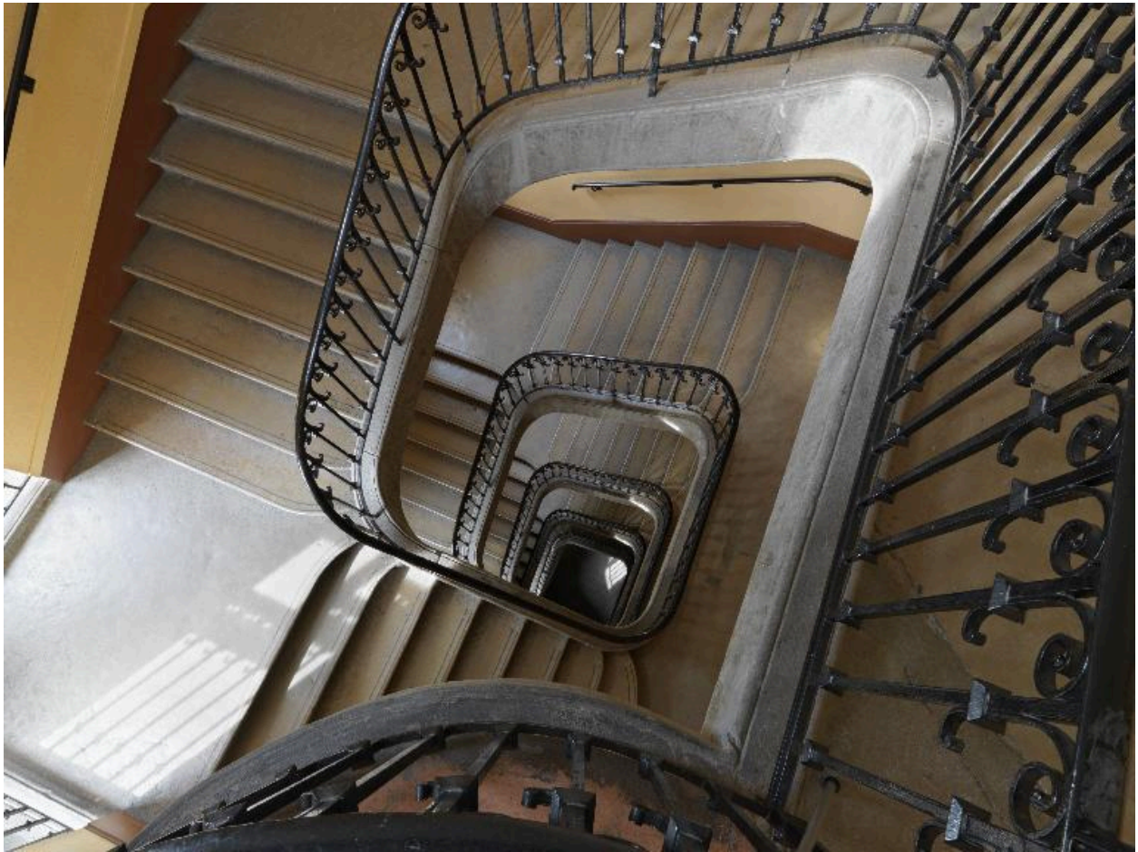
Escalier sud, cage vue depuis le dernier palier
