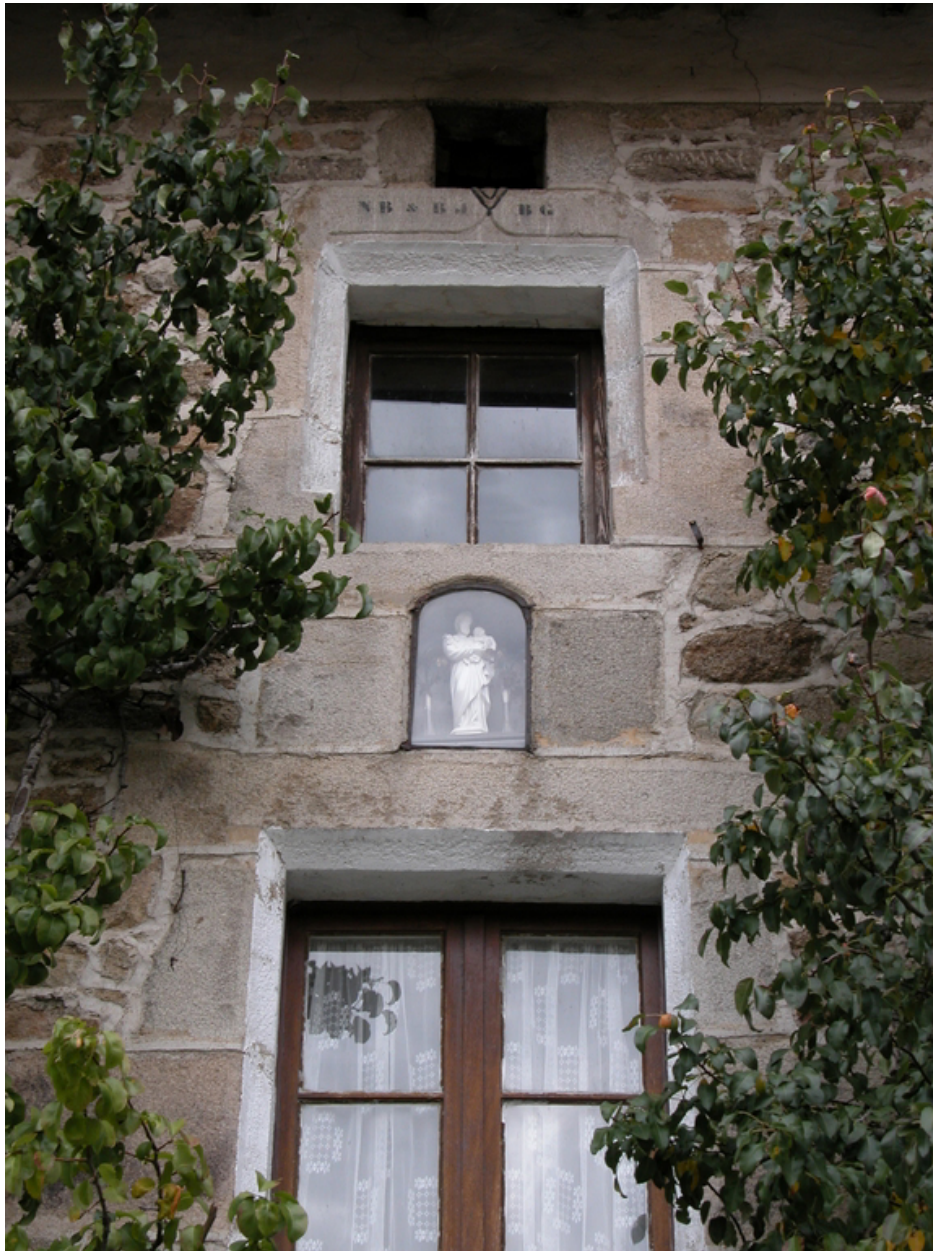
Détail de la façade du logis : niche à statuette, fenêtre à linteau en accolade.
