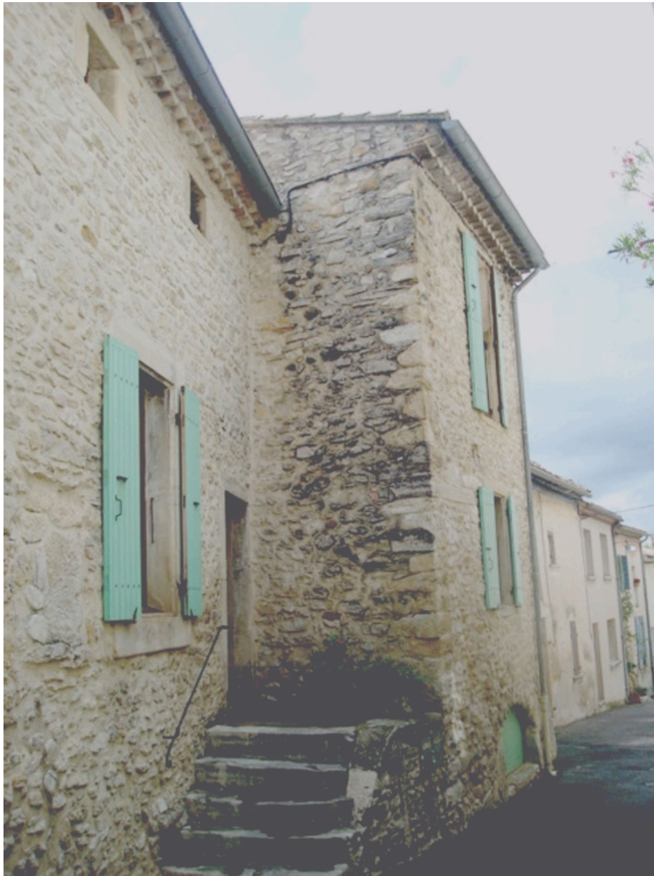
Le Pègue, village. Maison de la rue haute (B3 1036), vue d'ensemble.
