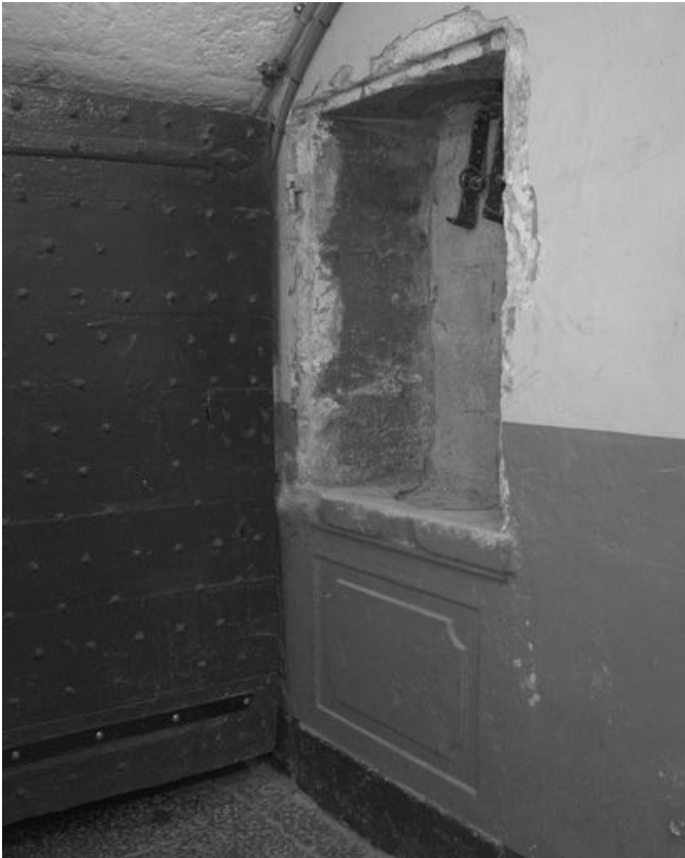
Escalier, palier du rez-de-chaussée, puits
