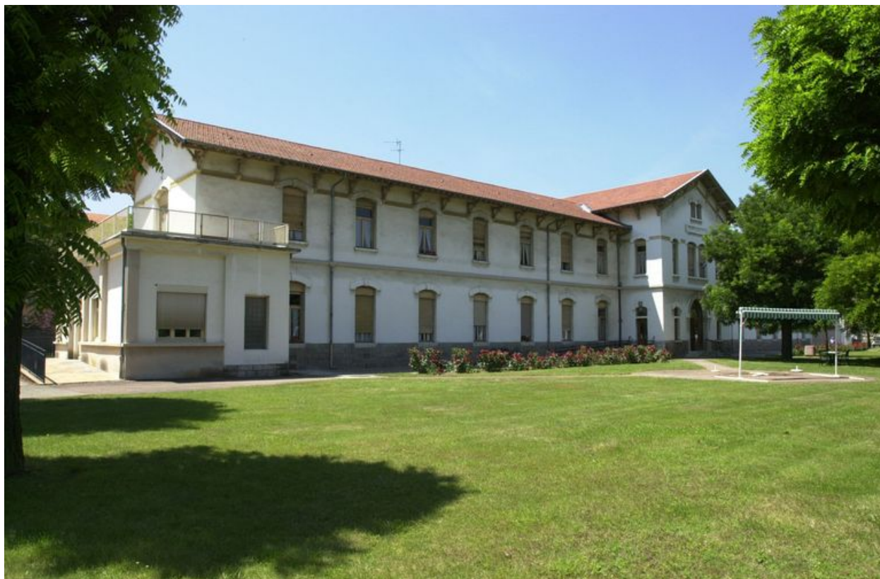
Façade principale, partie gauche
