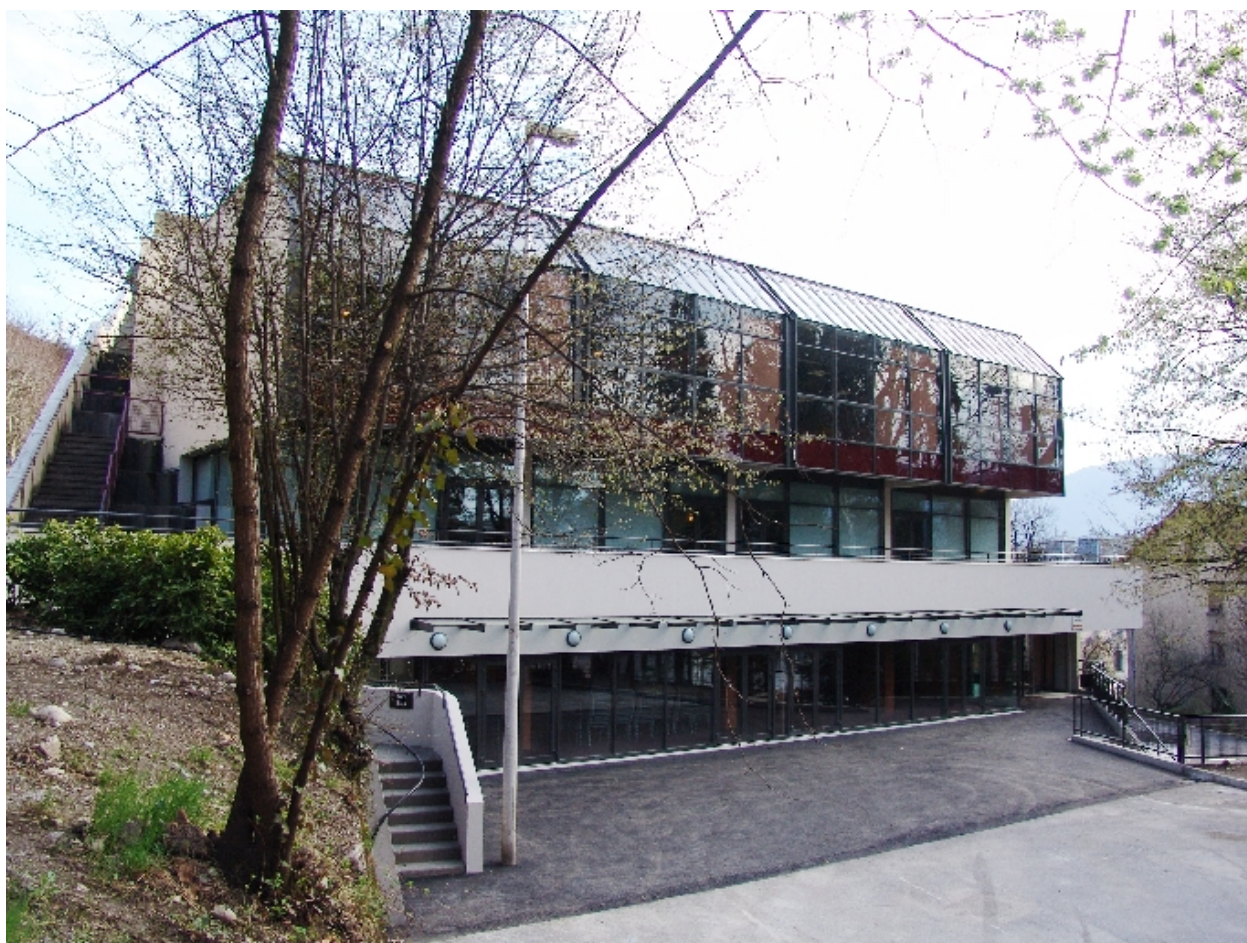
Façade nord de la partie orientale
