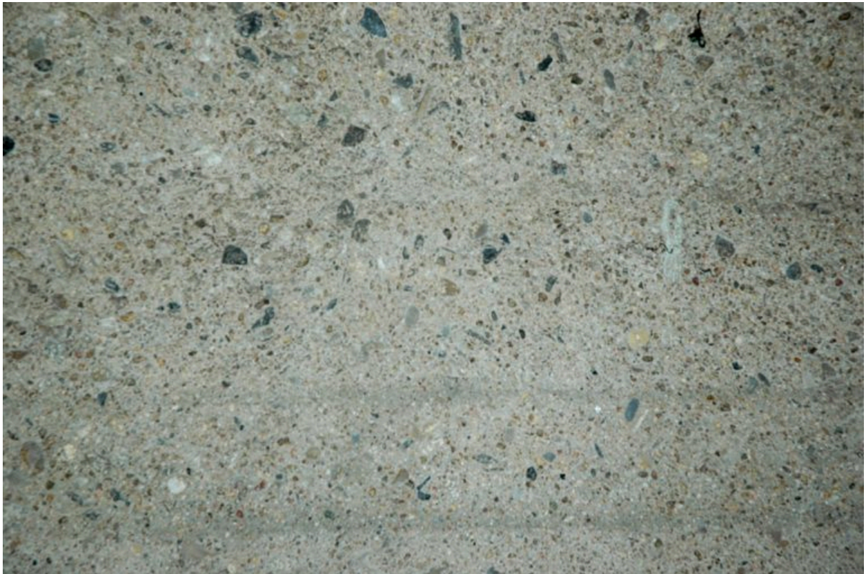
Détail du matériau du gros-oeuvre
