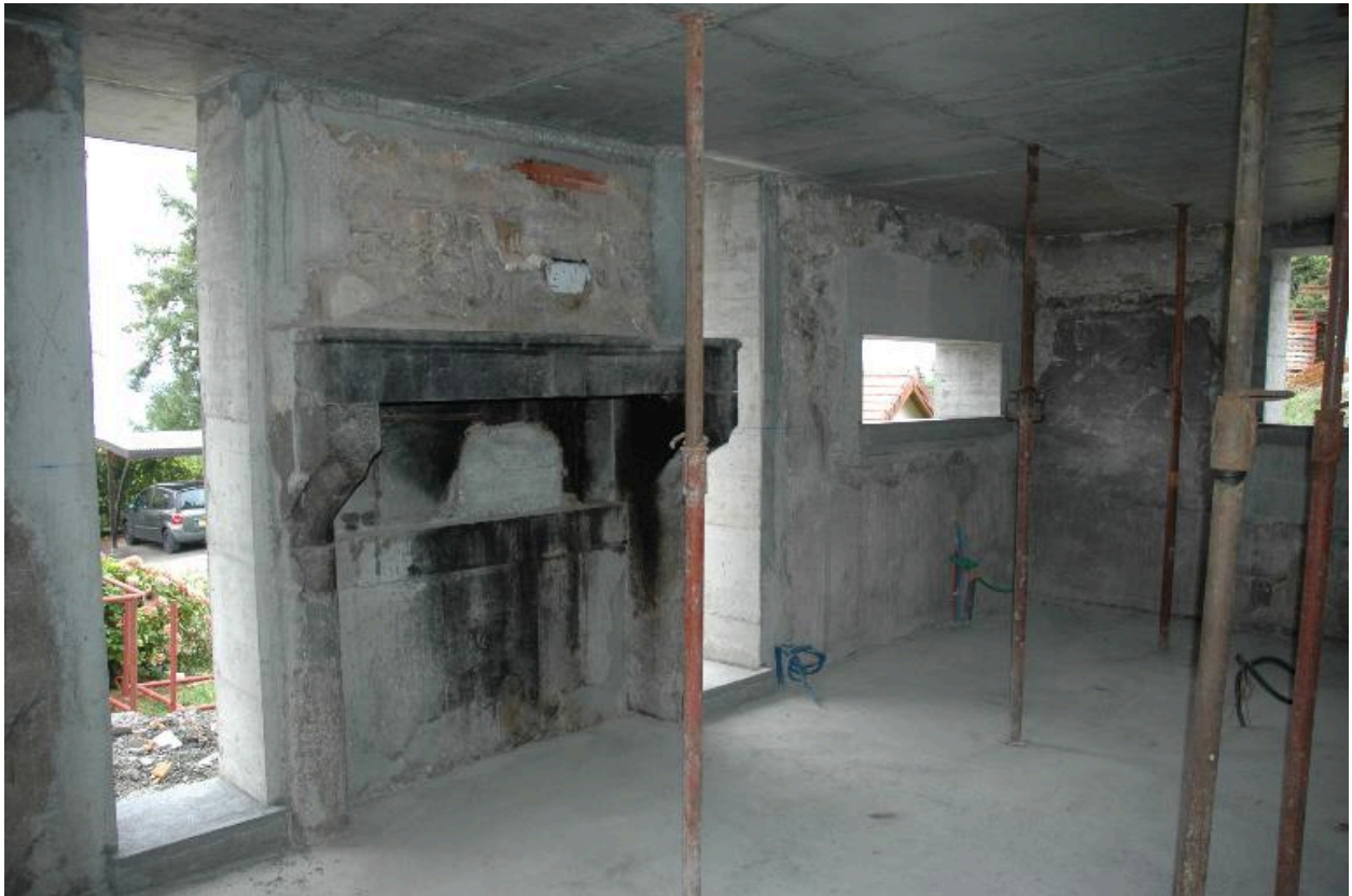
Intérieur de la cuisine de la ferme en cours de rénovation.
