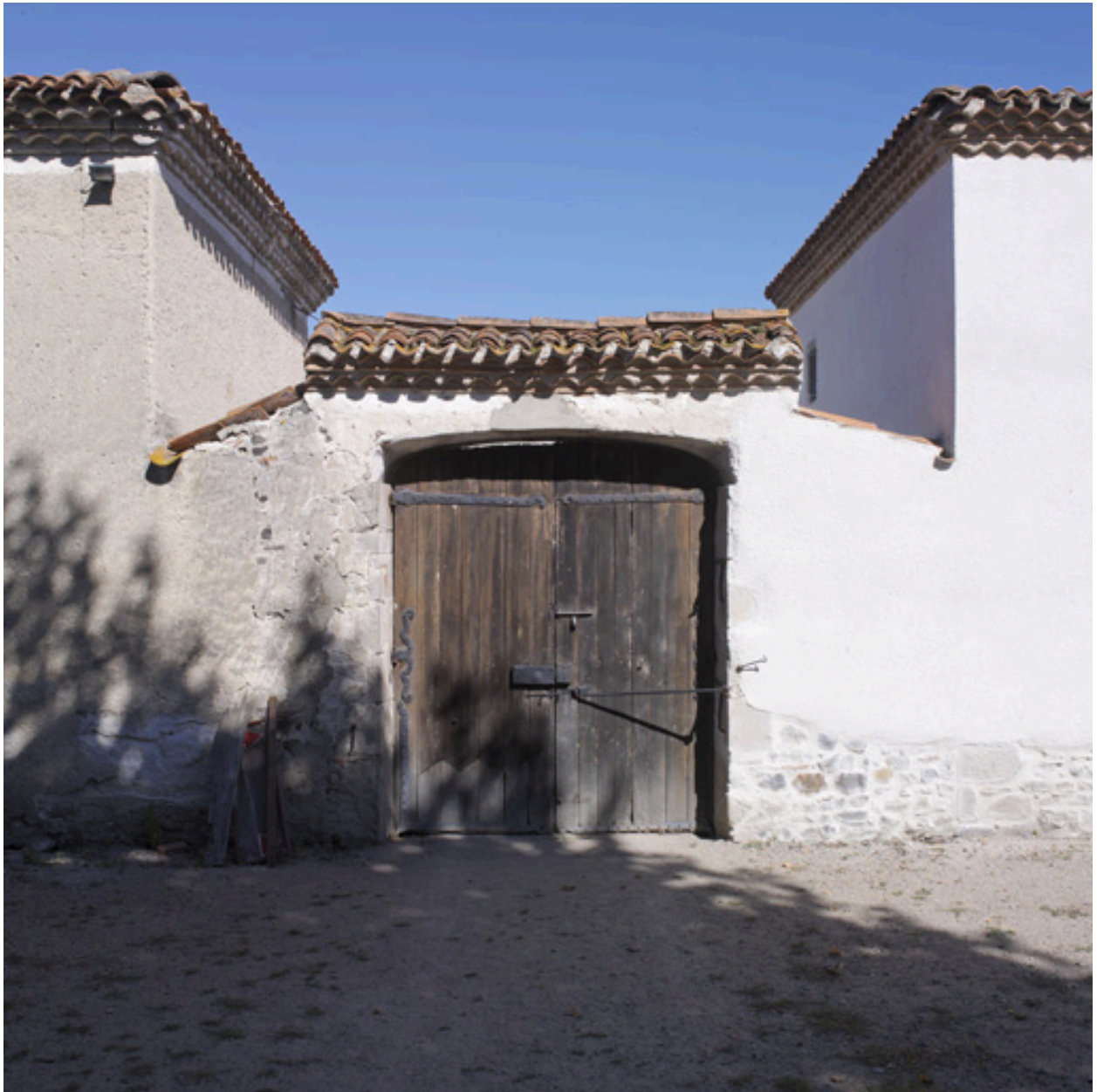
Vue du portail de la cour de la demeure, depuis l'est.
