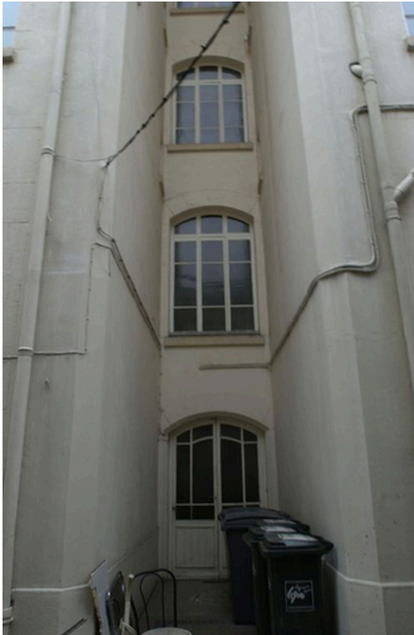
Cage d'escalier, vue extérieure du rez-de-chaussée
