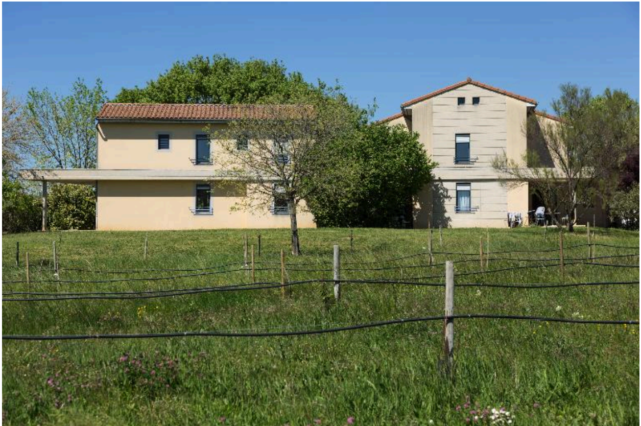
Gites : façades sud
