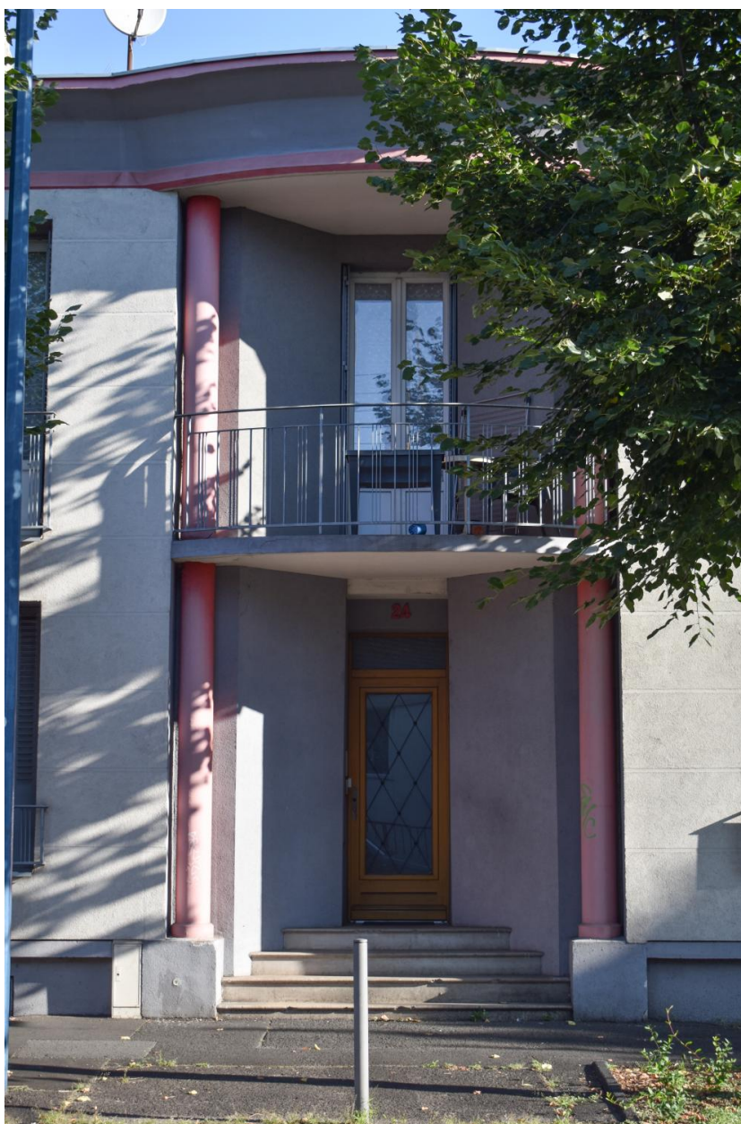
Travée centrale de la façade
