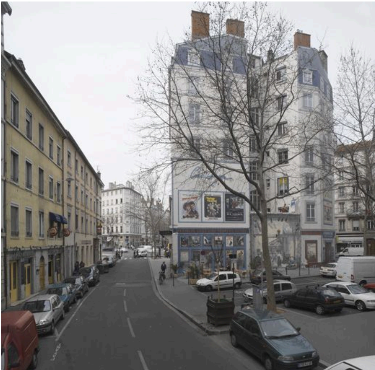
Vue d'ensemble vers l'ouest depuis la place Gabriel-Péri (passage entre le cours Gambetta et la Grande rue de la Guillotière)
