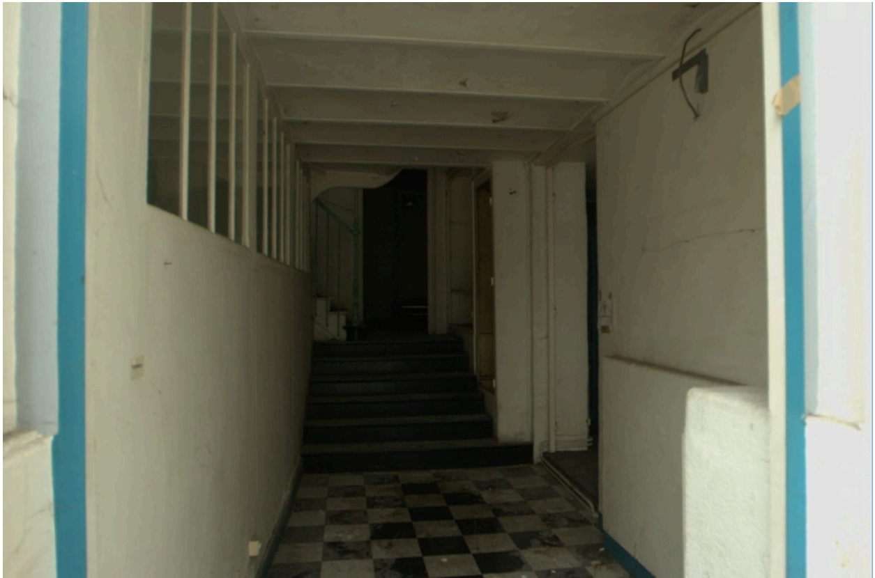
Espaces connexes à la halle (anciens bureaux)
