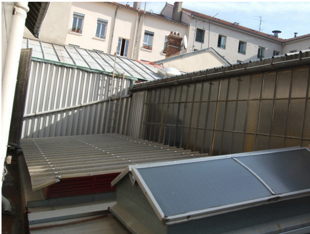
Vue de la toiture
