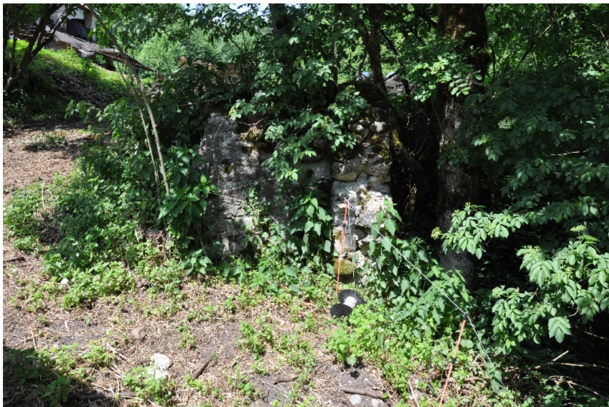
Vue du moulin aval, façade ouest
