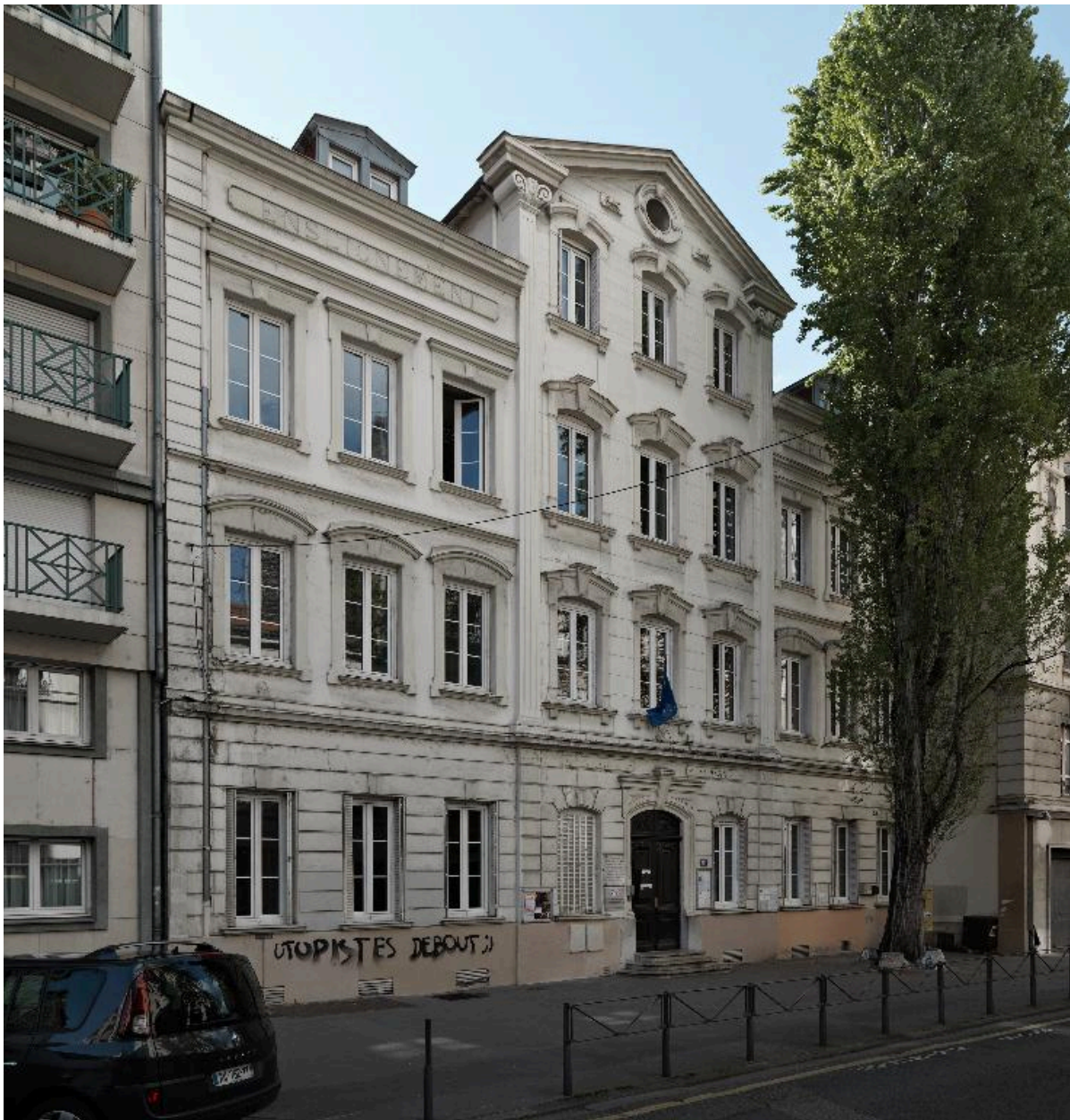
Vue générale de l'élévation sur rue
