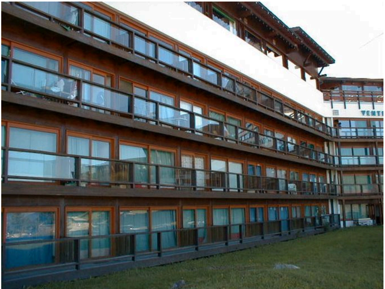
Arc 1600. Immeuble Pierre Blanche. Immeuble parallèle à la pente avec galerie latérale et coursive horizontale. Façade ouest
