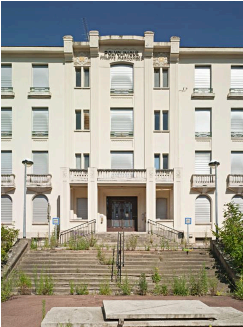
Hôtel-Dieu de Clermont-Ferrand. La polyclinique, avant-corps central de la façade principale.
