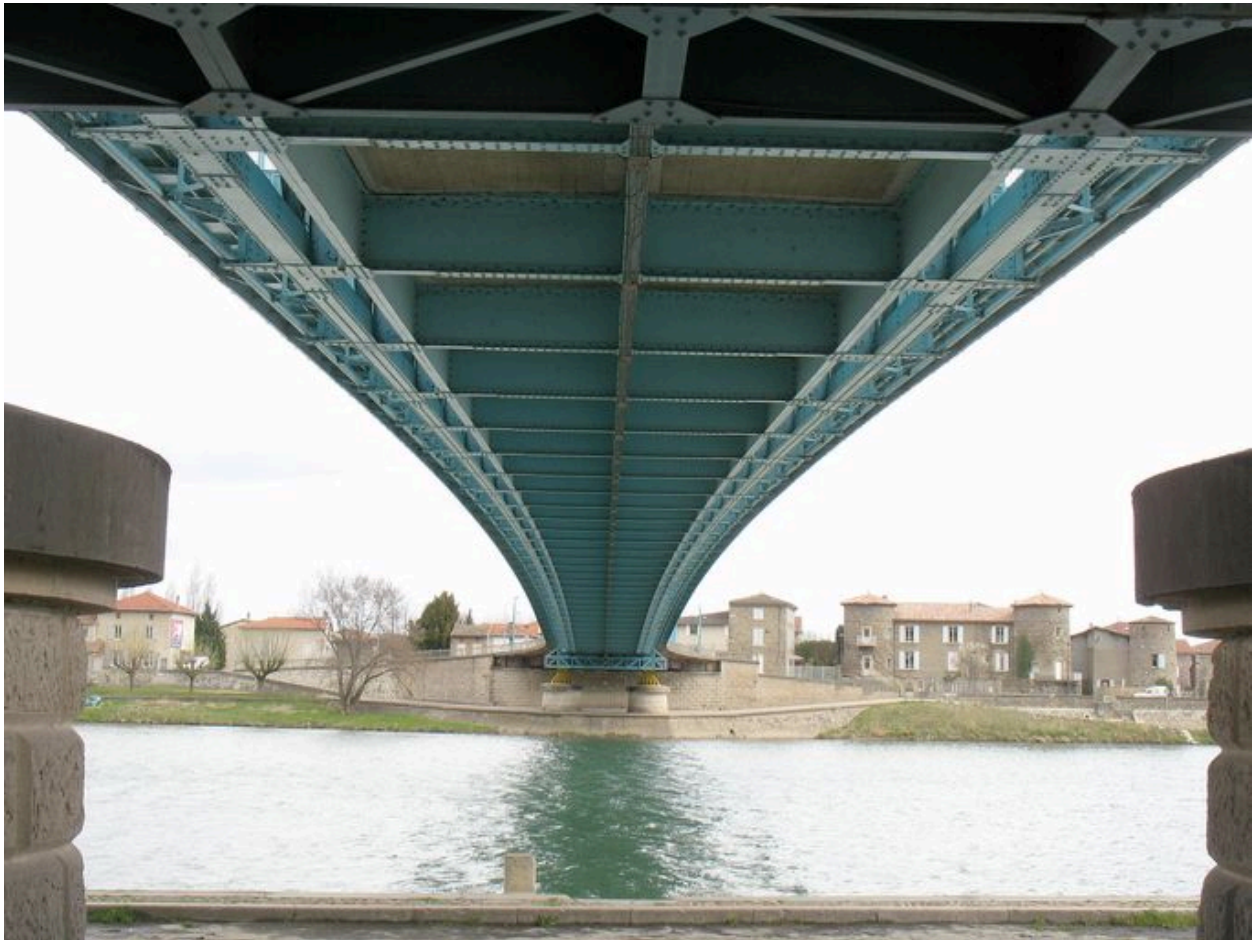
Vue du dessous du tablier, depuis la rive droite
