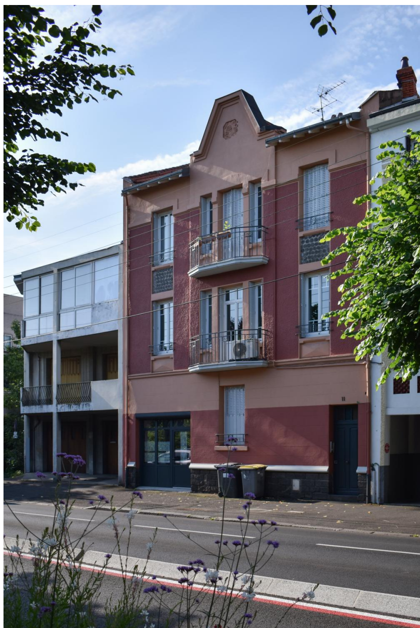
Façade sur le boulevard Jean-Jaurès
