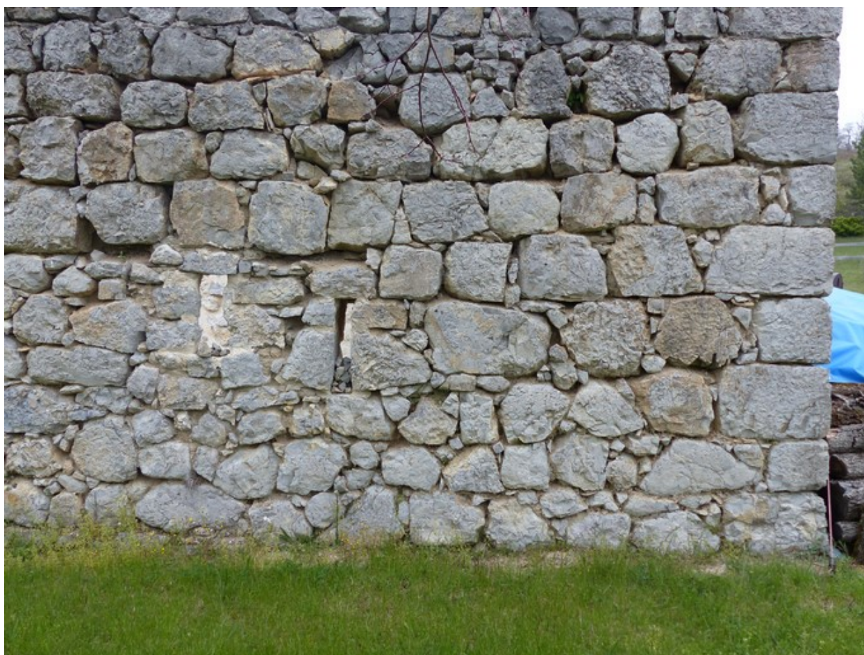
Maçonnerie d'un bâtiment de la ferme du Pied du Clos.
