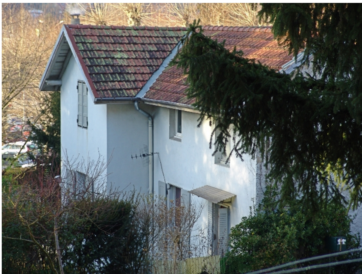
Vue générale prise du S-E
